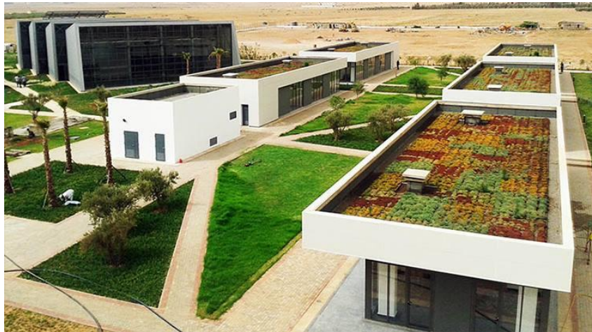
Figure 2: Toiture végétalisée réalisée par la société Ecovegetal Maroc à Oujda
