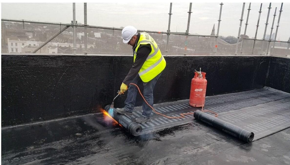
Figure 20 : Travaux d'étanchéité (source : Travaux d'étanchéité - 8 types courants de matériaux d'imperméabilisation (snayi.com))
