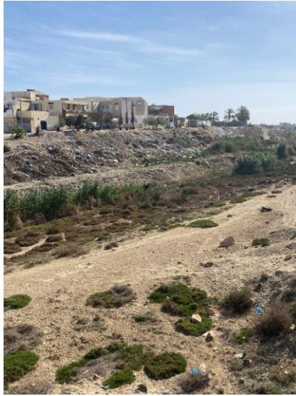
Canal de l'oued Gabès, Centre-ville, Lieu de rejet des gravats de construction, 13 avril 2022
