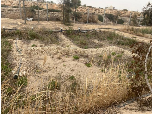
Projet de valorisation des eaux usées par l'association ACDD, Station pilote écologique, Etat des bassins résultant du manque d'entretien et au non fonctionnement de la pompe, 14 avril 2022
